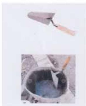
Preparare un secchio di malta e con la cazzuola murare accuratamente lo scasso del solaio intorno ai tubi possibilmente per 15/20 cm di profondità del solaio.
